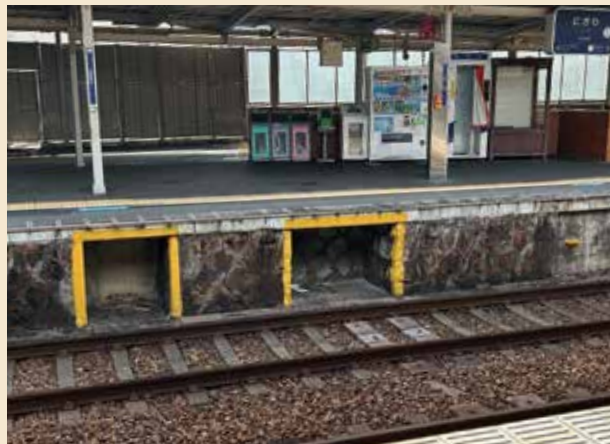
仁川駅下りホーム 中央付近
